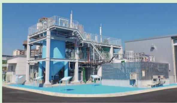
国交省のプロジェクトにより建設された神戸市東灘処理場で稼働中のリン回収施設「リフォスマスター®」
